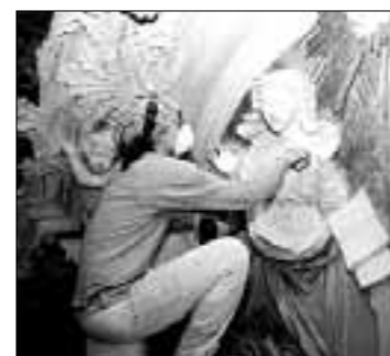
I lavori di restauro fatti nel 2004
