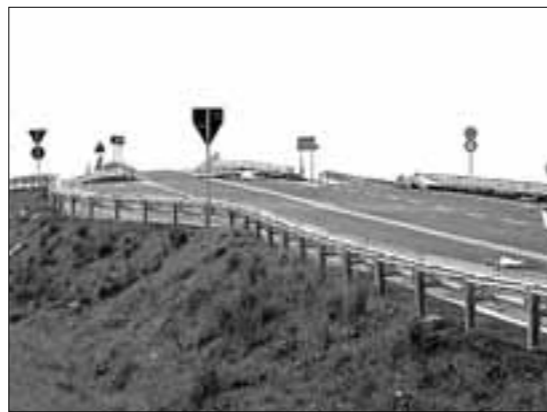
FIorenzuola - La tangenziale. «Tra un paio di settimane - dice il sindaco Compiani - saranno appaltati i lavori per la costruzione delle barriere antirumore al quartiere Molinetto» (foto Lunardini)
