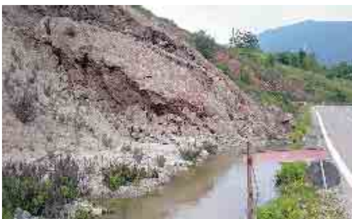
MORFASSO - Colata di terra presso la strada di fondovalle a Case Bonini (f. Saccomani)
