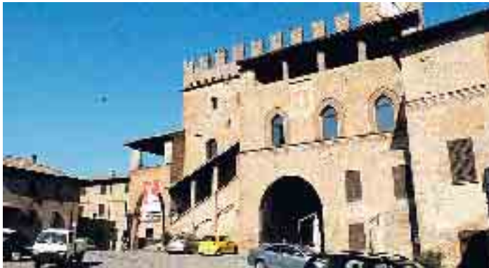
CASTELLARQUATO - Palazzo del Podestà. Si cerca un accordo per le strutture turistiche
