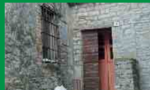
MALVISI: Fabbricato in sasso
