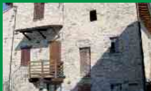
RAVAZZOLI: Rustico in sasso semindipendente da ristrutturare, con area cortilizia.
