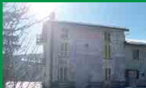
OLZA: Vecchia abitazione da ristrutturare
